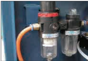
Figura 12 (separador duplo de óleo-água)
