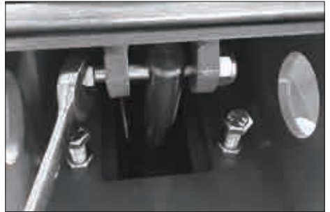
f. シリンダーロッドをボルトでタワーに接続させる
